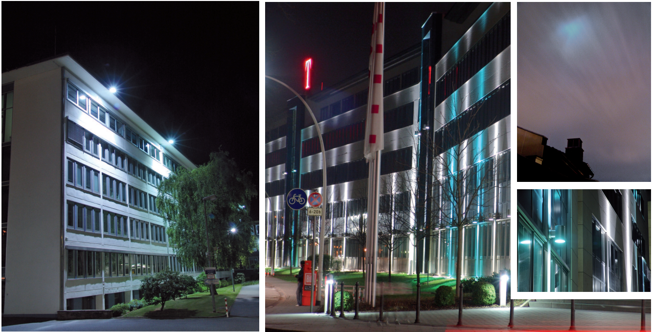
Abb. 6: Die Fassadenbeleuchtung am Gebäude auf dem Bild rechts wurde aus Sicherheitsgründen installiert und soll trotz Problemen für den Vogelschutz nicht umgerüstet werden. Das Licht strahlt weithin sichtbar nach oben ab und irritiert ziehende Vögel. Sicherheit für Menschen und Vögel auf dem Bild links: Die Leuchten am Dach sind nach unten ausgerichtet und beleuchten die Fassade, lassen aber den Luftraum darüber dunkel.
