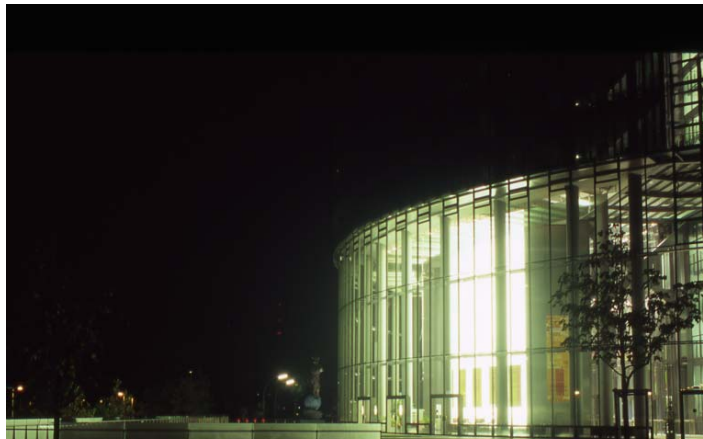
Abb. 3: Einer der beiden ca. 150m 2 großen Wandfluter an der Südseite des Turms. Nach dem morgendlichen Einschalten (ca. 06:00 h) sind aufgeregte Rufe der jenseits des Vorplatzes in den umliegenden Gehölzen sitzenden Vögel zu hören; einige fliegen die Scheiben an und kommen hier zu Schaden.
