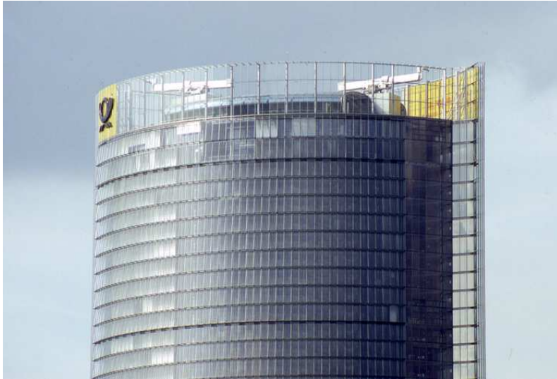
Abb. 12: Vogelfalle Turmdach: Großvögel wie Tauben und Greifvögel gelangen zwar hinein, aber aus eigener Kraft nicht mehr aus dem Bereich zwischen den Glaswänden hinaus. – An der rechten Seite des Gebäudes ist eine der beiden „wing walls“ zu erkennen.
