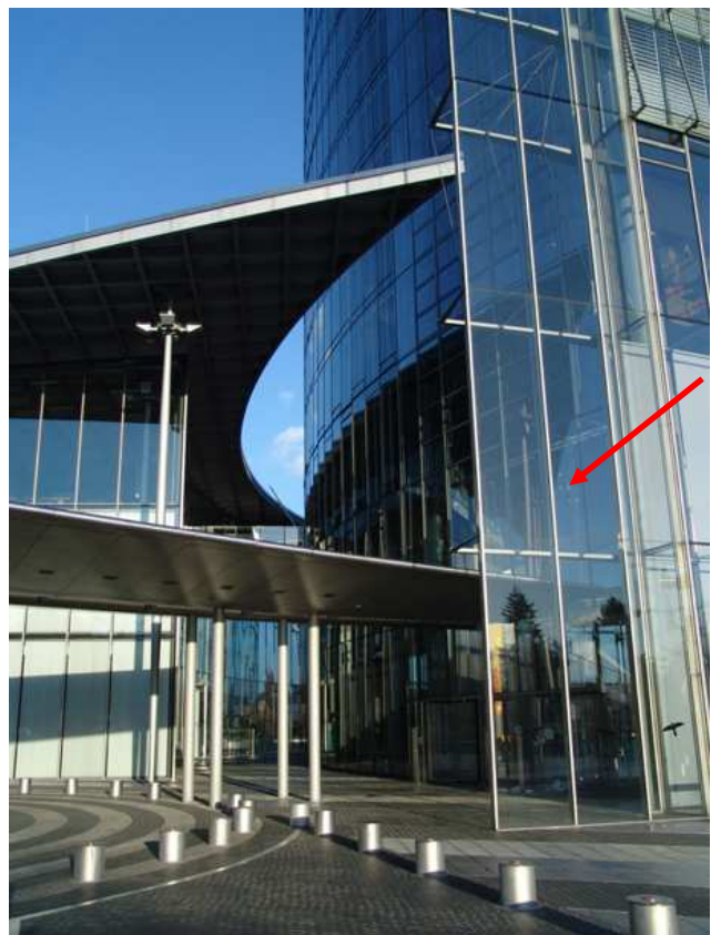
Abb. 13: Blick vom Haupteingang aus Richtung Westen in die Passage zwischen Turm und Lounge/Kasino (linkes Gebäude). Am rechten Bildrand ist eine der beiden „wing walls“ (Pfeil) zu sehen.
