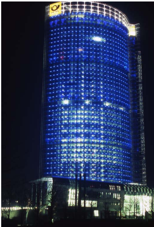
Abb. 1: Post-Tower während der Illumination. Im Vordergrund unten der Konferenztrakt mit Kasino. Aufnahme aus Nord.
